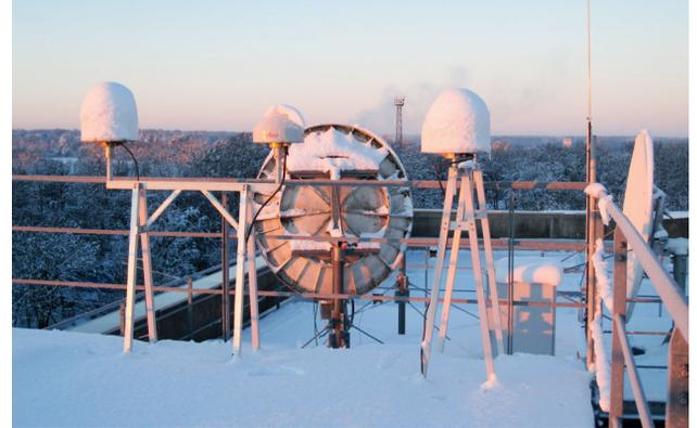
Drei Antennen für den Empfang von Signalen von Navigationssatelliten und zwei Antennen für Zeitvergleiche über Telekommunikationssatelliten auf dem Dach des Meitner-Baus in der PTB.
